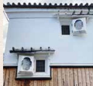
⑩平野郷・町家ゾーン： 江戸期の商家(上)「藤岡家」(下)「粕谷家」 HOPEゾーン事業「まちなみ修景補助」が活用されている
