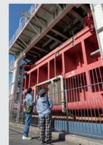
伝法川と淀川の合流地点にあるのが伝法水門。伝法川は埋め立てられ、水門から続く水路と船溜まりがその名残り。伝法水門は遠隔操作が可能で、閉じる際には赤い部分が真下に降りる。
