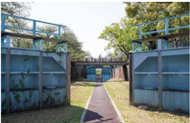
赤煉瓦の壁が目印の『毛馬第一閘門』。観音開きの扉は、背の高い船も通れる仕様だ。
