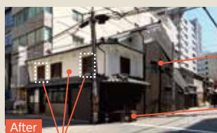
中央窓の意匠に合わせて 窓格子を再現、既存塗料 を落として白漆喰塗
