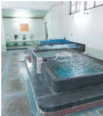
浴槽の外側を囲むように腰掛け用の段差。 ここに座って浴槽のお湯で体を流すためのものだ。
