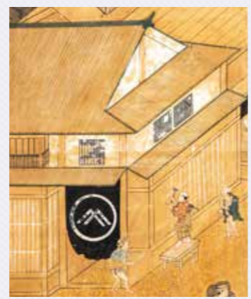
図1 出格子を造作する大工
