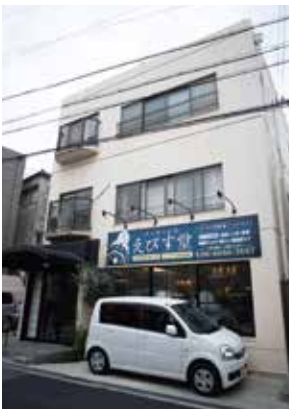
見守りシェアハウス弁天堂の立ち上げ時には、国の補助金を活用して改修を行い、セーフティネット住宅として登録している。
