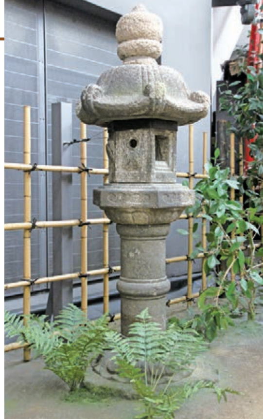
▲石灯籠の耐震補強 石灯籠の上部に鉄製バンドをまき、背後にある鉄の支柱につなぎとめて耐震補強をしている例
