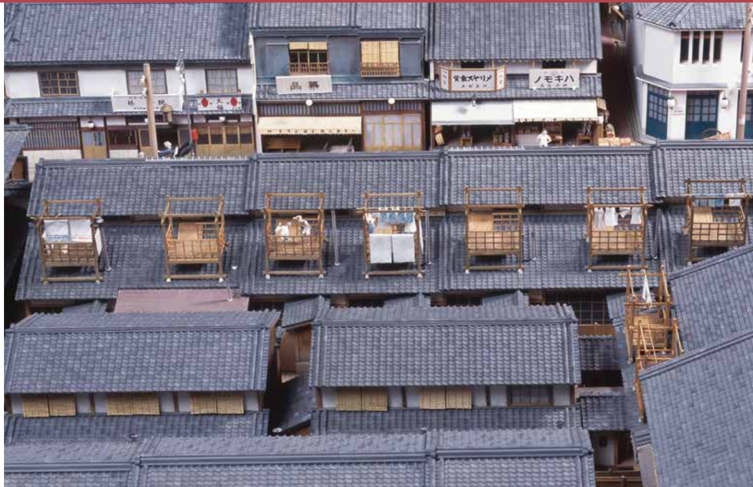
写真上部は空堀商店街の街並み。表長屋の裏側には物干し台が並ぶ。その裏（写真下部）には裏長屋がびっしり。
