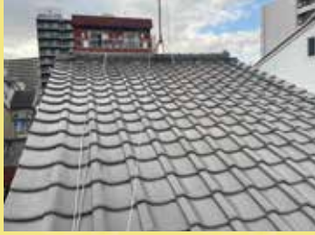
施行前は瓦屋根だった。趣があるが、耐震には不利。
