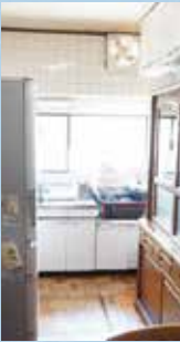
工事前の台所。工事の中で最も悩んだのが窓を残すかどうかだった。
