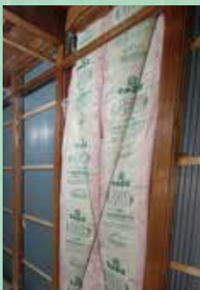
壁の中に筋交を追加し補強する。壁の厚さは変わらないので部屋も狭くならなかった。
