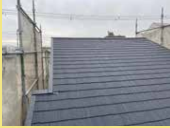
葺き替え後の屋根。瓦と比べてかなり軽くなり耐震化に有効な改修だ。
