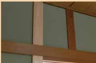
工事後。明るい色の柱は補強のため新たに追加した部分。元ある柱や梁は残している。
