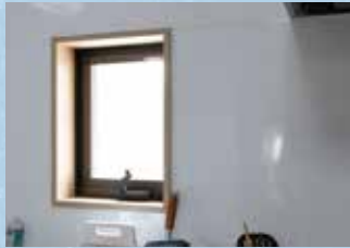
工事後。台所の窓は、壁を増やすため明かり取りの小さな窓を残して閉ざした。
