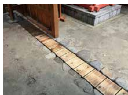
薬屋裏庭の排水溝 敷地境界には石組の溝が裏に延びる。
