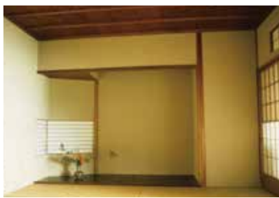
吉田五十八が手がけた杵屋別邸の居間。 床の間の柱や障子の縦棧が省略されている。
