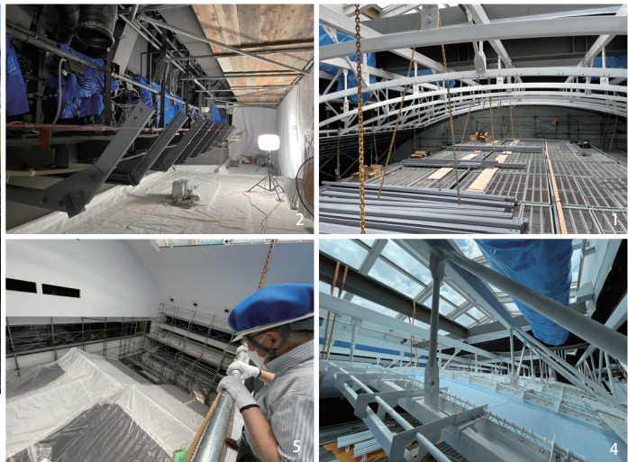
1.膜天井骨組、吊り足場 2.キャットウォークの設備養生 3.養生した町並みとその上空にある吊り足場 4.膜天井骨組 5.吊り足場からみる町並みと展望フロア 6.天ちゃん六ちゃんの養生
