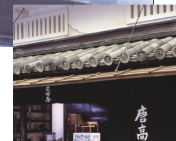
本瓦葺の町家(唐物屋)
