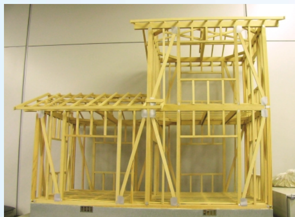
構造(在来工法)と耐震補強を知ってもらうための会員お手製模型
