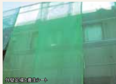
外壁足場と養生シート
