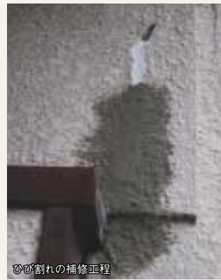
ひび割れの補修工程
