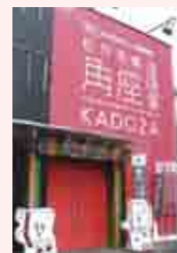
平成25年7月に復活オープンした道頓堀角座
