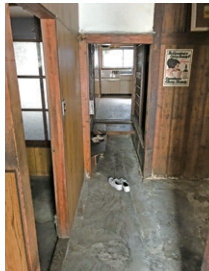
改修前の状況
