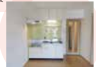
台所設備の新設・改良
