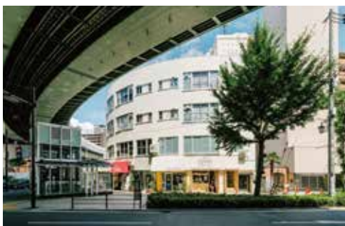
新桜川ビルに沿うように高速道路が完成した。交通量が多く騒音も大きい。
