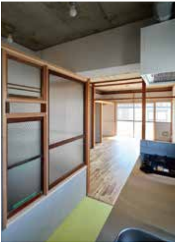
(3) 木造アパートの建具を再利用した。部屋ごとに組み合わせが異なる。
